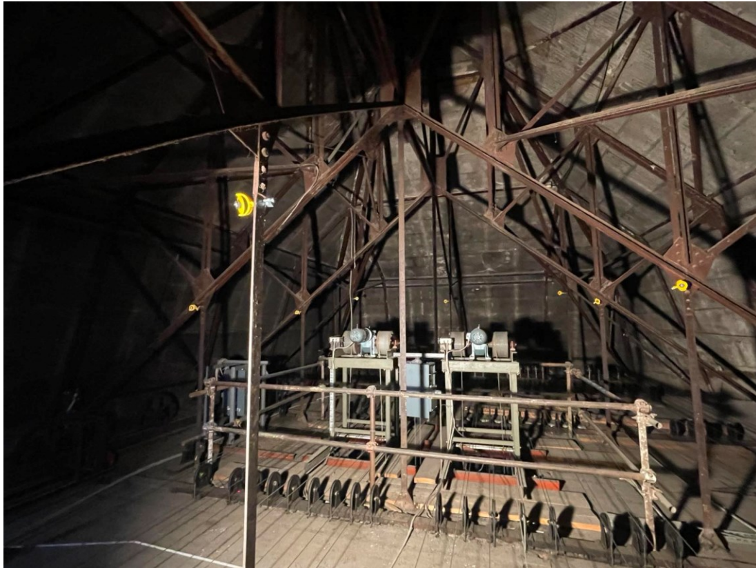
Slika 1: Predmet izmere je bila jeklena konstrukcija strehe Ljubljanske Drame.
